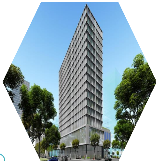
The Cobi Tower 2 Hạng: B – Quận 7 GFA: 23.000 m 2
